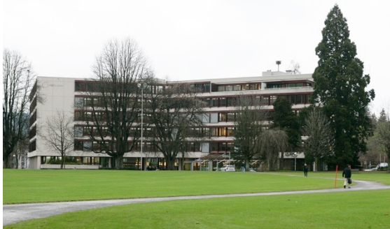
3 - Schulhaus Kreuzbleiche (fertiggestellt 1984)
