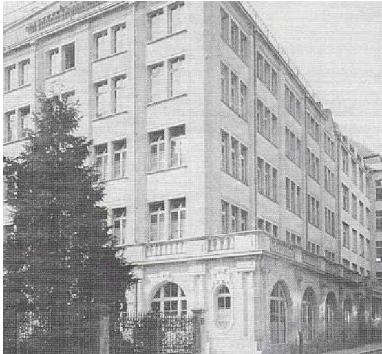
2 - Das ehemalige Schul- und Vereinsgebäude an der Merkurstrasse in St. Gallen (Abbruch 1984)
